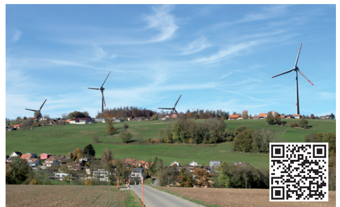
40 éoliennes entre Chasseron et Creux du Van
