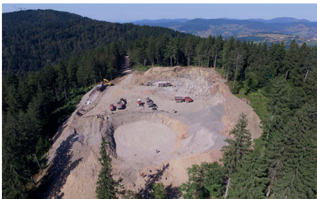
Chantier du parc éolien de Gersbach dans la Forêt-Noire.
